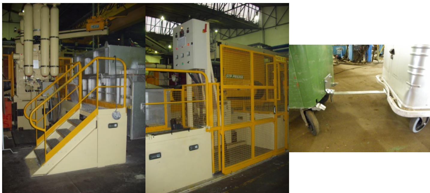
Aménagement de poste de travail
