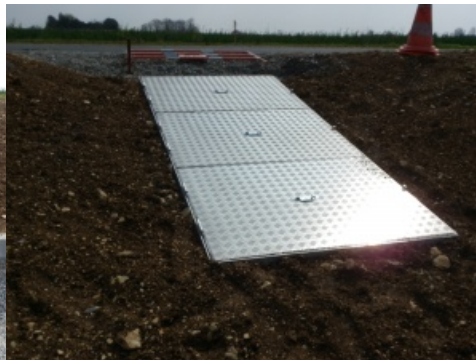
Trappe extérieur à 3 portes.
