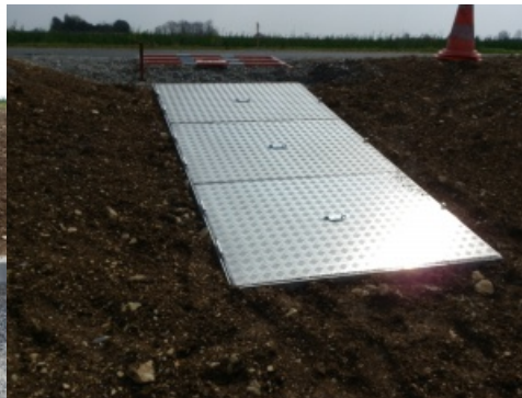
Trappe extérieur à 3 portes.
